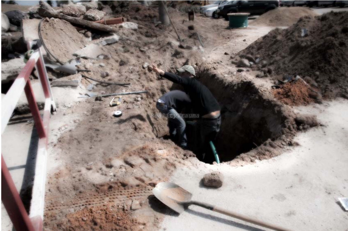
Digging the hole חפירת הבור
